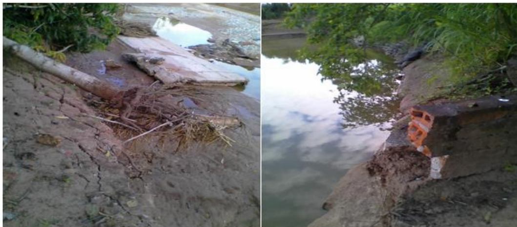
FIGURA N°02: TRAMO CRÍTICO EN EL RÍO SISA, SE APRECIA QUE LA INFRAESTRUCTURA DEL CANAL 24 Y LAT 25 HAN SIDO AFECTADAS, CON RUPTURA EN TRAMOS, POR DESPLOME DE LA RIBERA
